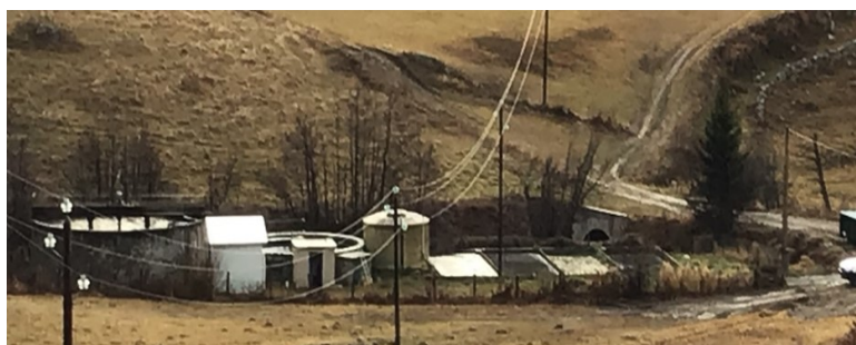
Station d'épuration de La Llagonne
