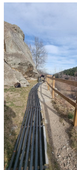
Installation des grilles
