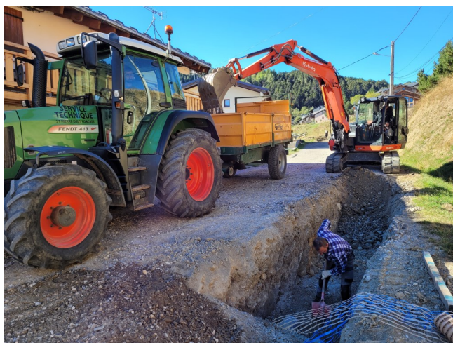
Travaux rue des écureuils
