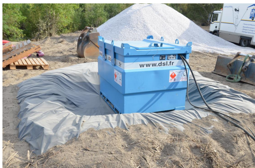
☞ Photographie 25 : Mise en place d'une aire étanche autour d'un groupe électrogène
