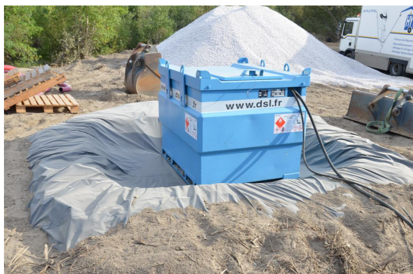
☞ Photographie 18 : Mise en place d'une aire étanche autour d'un groupe électrogène
