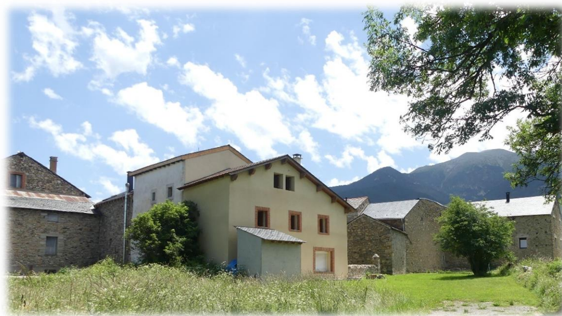
☞ Photographie 6 : Maisons du village sur site
