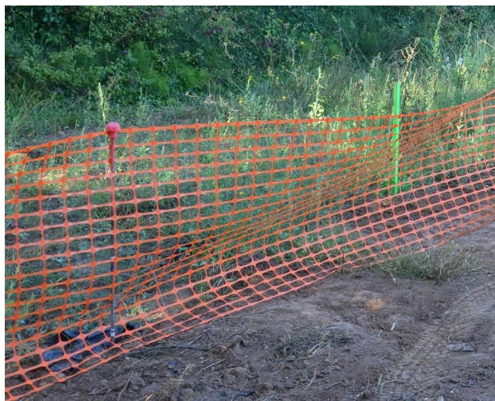
☞ Photographie 10 : Dispositif de limitation des emprises des travaux
