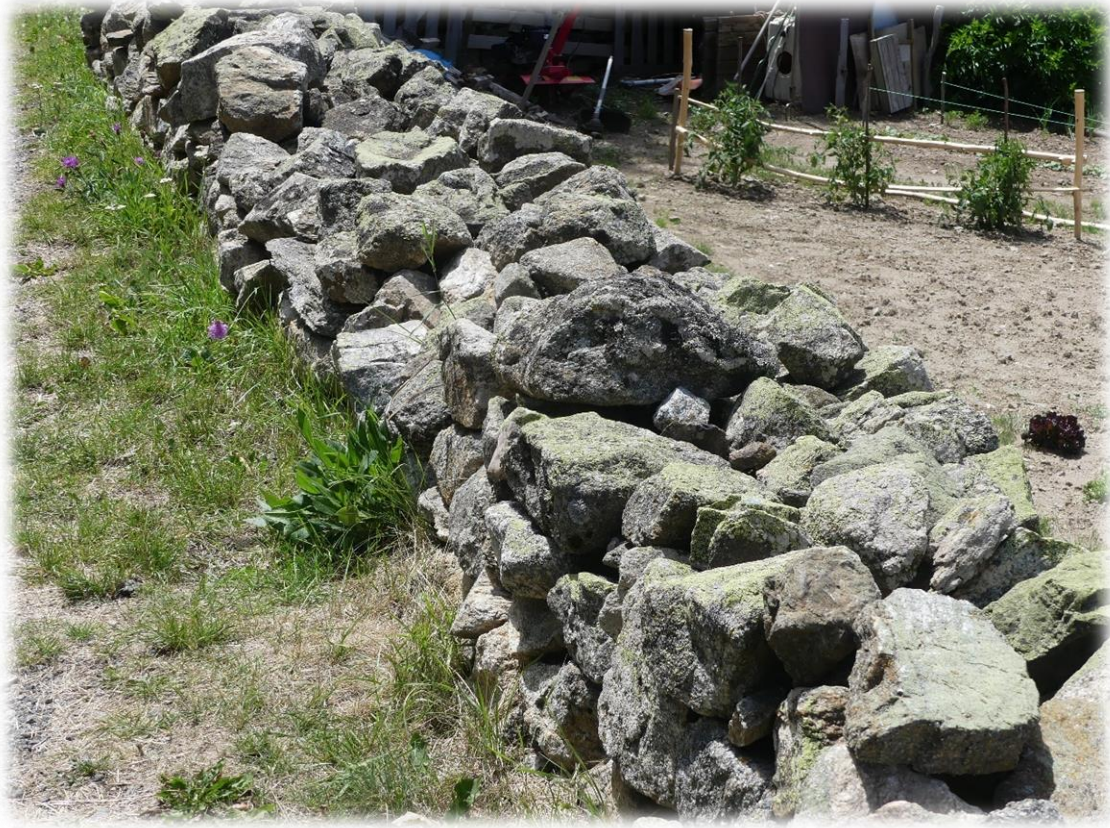
☞ Photographie 8 : Muret en pierre au Nord de la zone d'étude
