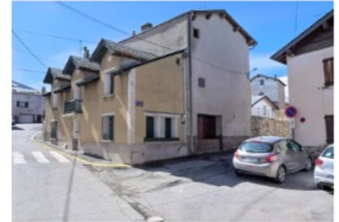
Vue 2 sur l'imp. Des Églantiers
